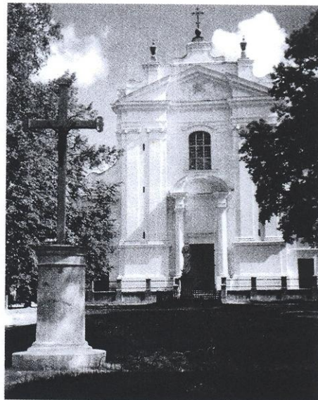
7. Krāslavas katoļu baznīcas fasāde. 1940
